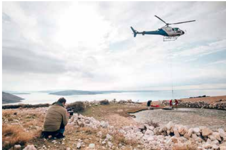
El transporte de las obras se hizo en helicóptero, lo que fue complejo debido al fuerte viento de la zona.
